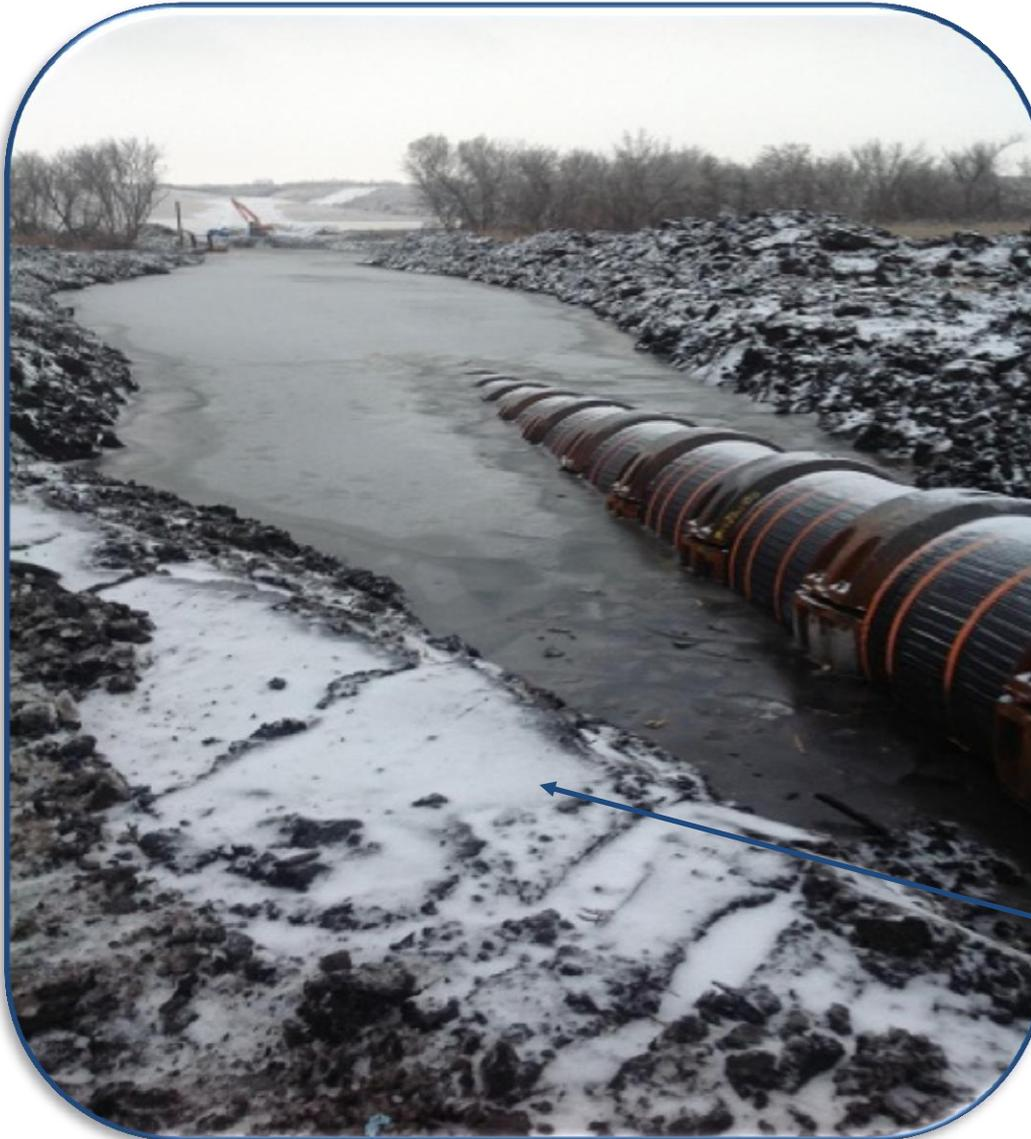
При строительстве подводного перехода магистрального трубопровода диаметром 1420 мм одной из главных задач было обеспечить устойчивость спецтехники на грунтах со слабым основанием.
